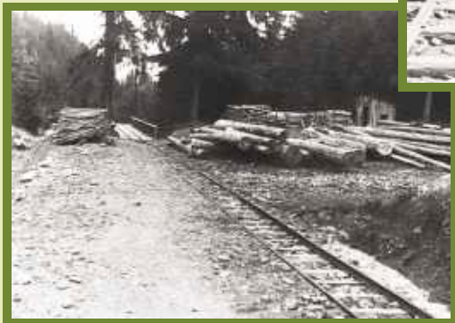
Zdj. 17 Składowiska przy kolejce wąskotorowej (ze zbiorów prywatnych Jerzego Honowskiego)
