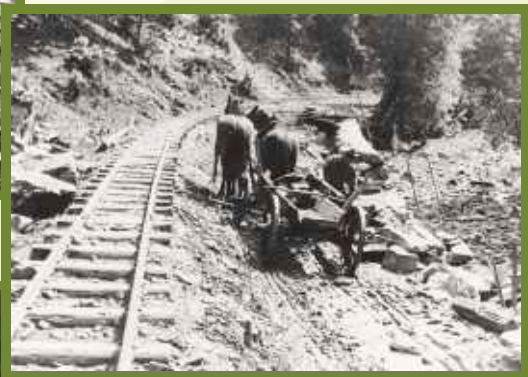
Zdj. 16 Prace przy torowisku kolejki (ze zbiorów prywatnych Jerzego Honowskiego)
